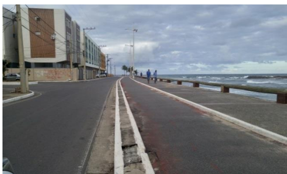
FOTO 20: vista da Rua Conde da Castanheira.
