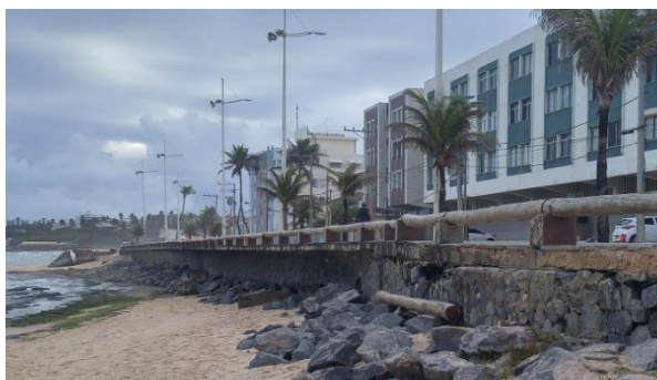
FOTO 23: alvenarias de pedra e calçadas em balanço.
